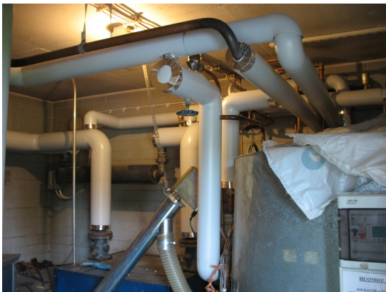
Urpo Uusi-Illikainen teki ison työn Koulun pannuhuoneen eristämässä.
