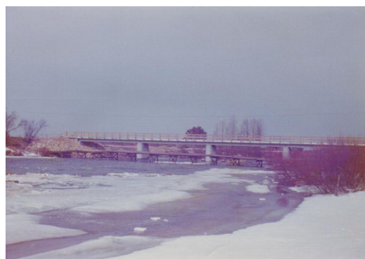
Uusi silta ja vanha silta rinnakkain.
