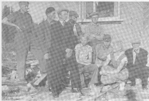
Lepotauko Alavainion talon rakennustyömaalla 50-luvun puolivälissä (iltamiin valmistautumista?). Vas. Lauri Salmela, Paavo Salmela, Olavi Puhakka, Sakari Perttu, Risto Salmela, Aaro Perttu, Matti Salmela, Hilda Salmela ja Jorma Perttu.
