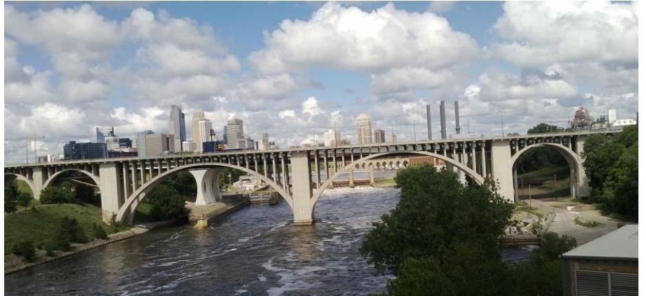
Kuvassa Missisippijoen ylittävä silta Minneapolisissa.
