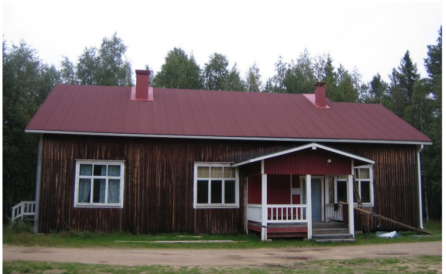
Livon seurojentalo, Ruostehovi, odottaa uutta ulkoverhousta
